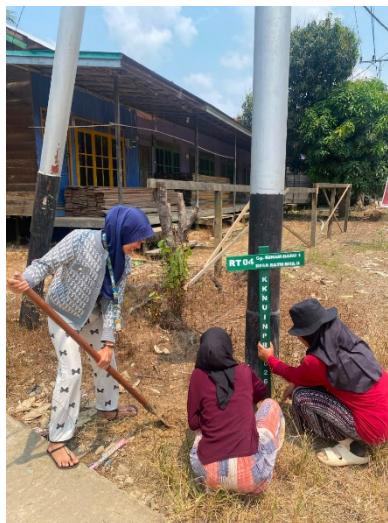
Gambar 7. Proses pemasangan plang
