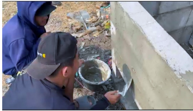
Gambar 1. Pembuatan awal rocket stove
